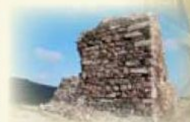
The ruins of the church in Sędziszowa
